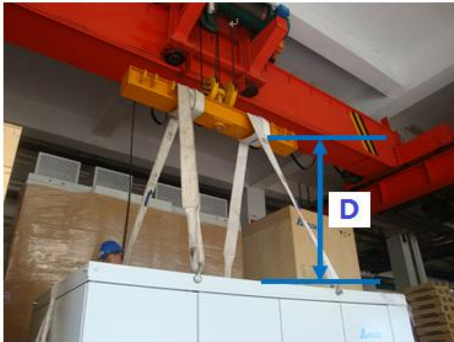
Рис. 6-11 Способ 1 перемещения краном
