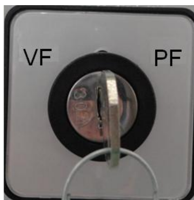
Рис. 3 Переключатель работы двигателя от преобразователя / от сети
